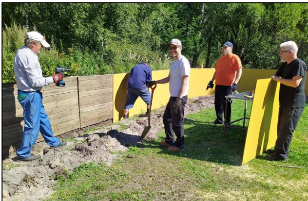
Kaukalon pohjoisseinämän levytystä, vasemmalta lukien Veikko Laulainen, Kari Lönnberg (selkä kuvaajaan), Juha Kujanpää, Harri Usmi, ja Kari Esselström.
