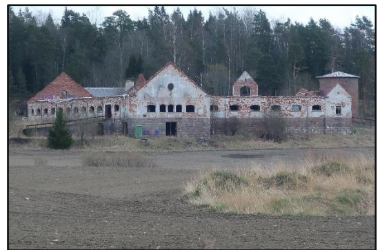
Kuva 3. Sonnimäen navetta tulipalon jälkeen.
